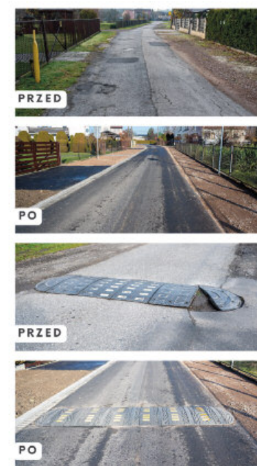
EFEKTY MODERNIZACJI UL. ŚW. JANA W SPYTKOWICACH
