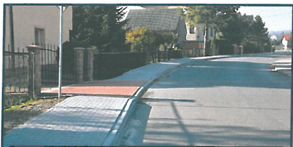
Budowa chodnika w ciągu drogi powiatowej ul. Jana III Sobieskiego w Ryczowie
