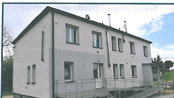
Remont budynku komunalnego w Ryczowie
