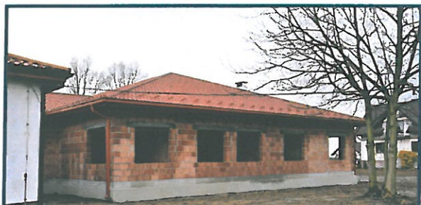
Budowa pierwszego na terenie gminy Spytkowice zółbka
